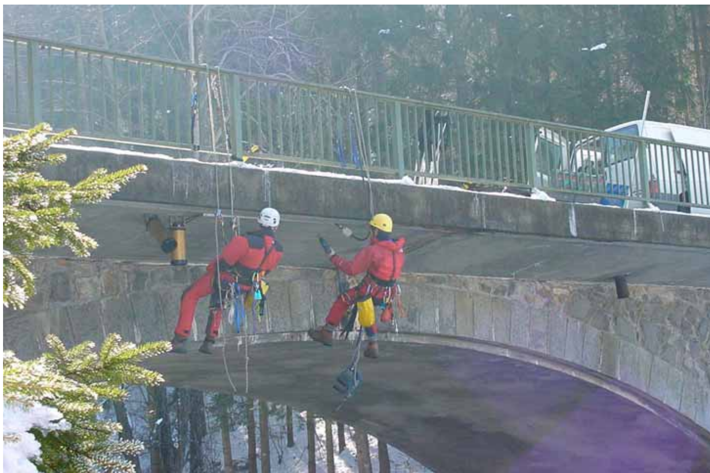
Figure 2 : SIMK® - Montage sur pont de deux radars produisant une mesure sans contact en continu du niveau et de la vitesse sur la rivière Ilz (WWA Passau / Allemagne)
