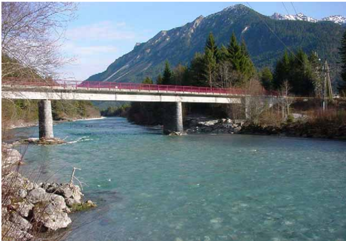
Figure 26 – SIMK® Station de débit au fil de l'eau par radar sur Vorderhornbach / Lech du Tyrol / Autriche (commande : E.ON HydroPower GmbH)
