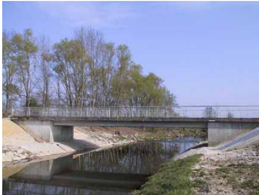
Figure 21 – Station de mesure au fil de l'eau par SIMK® ultrasons temps de transit Bruckhäuser / Kollbach Allemagne (commande WWA Pfarrkirchen)
