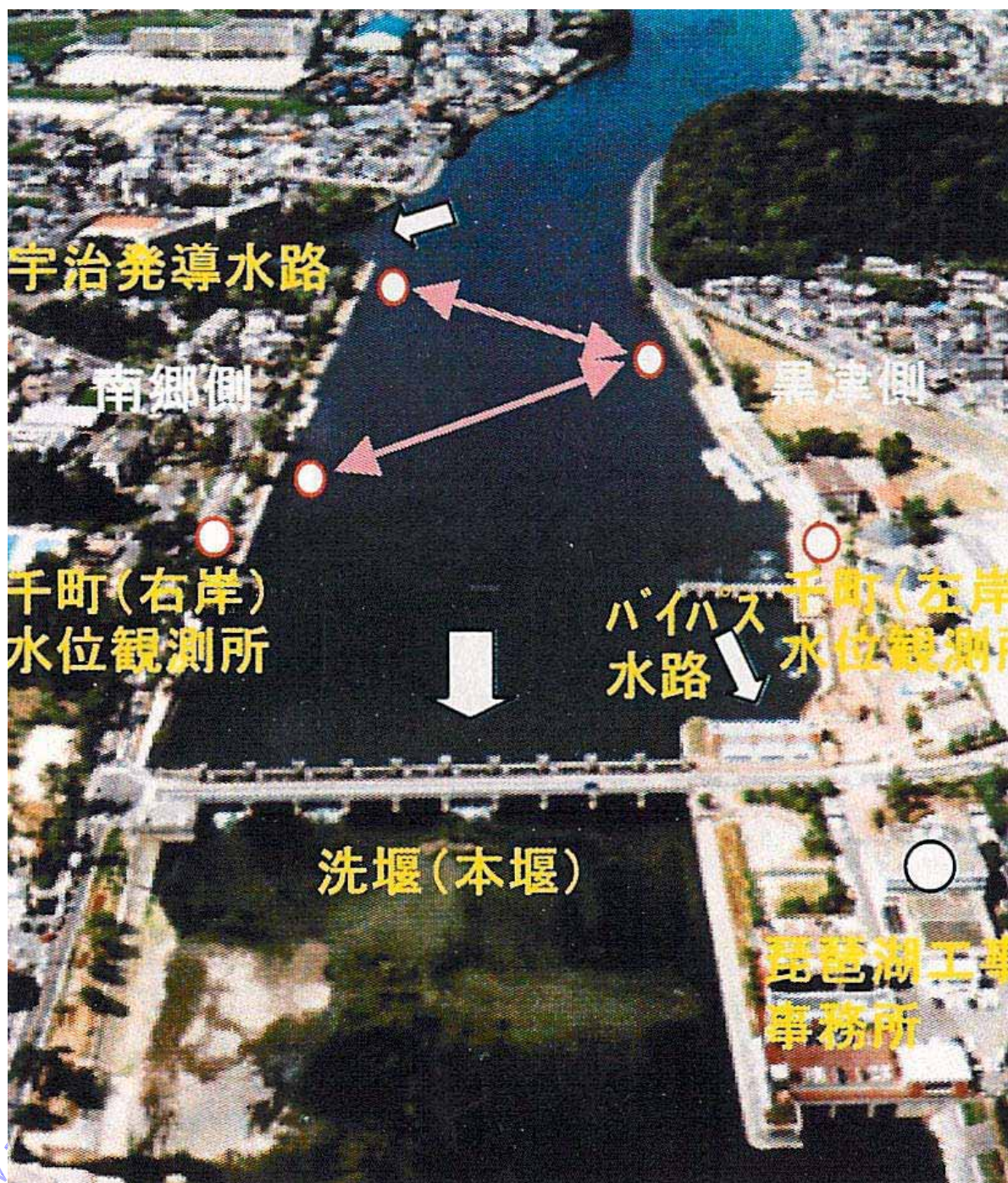
Figure 25 – SIMK® - Station de débit au fil de l'eau par ultrasons temps de transit, localisée directement en amont du déversoir Araizeki de largeur 130 mètres sur la rivière Seta au Japon.
