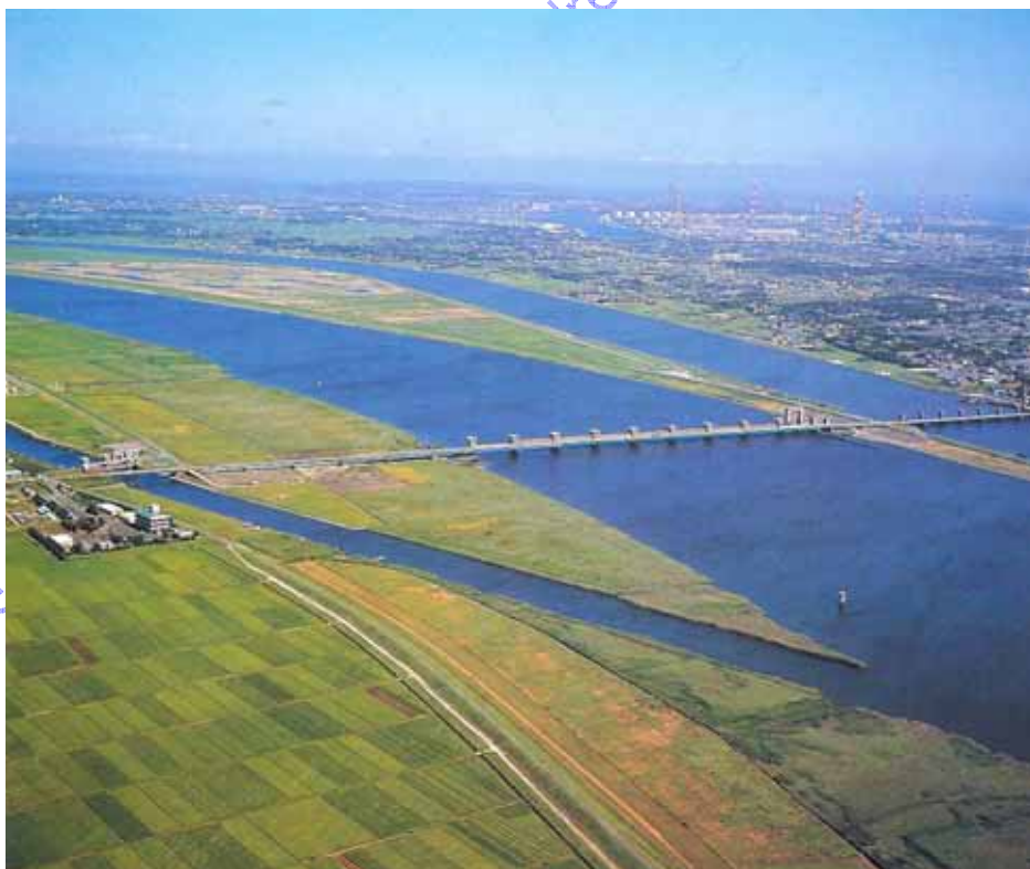
Figure 27 – SIMK® Station de débit par ultrasons temps de transit localisée en amont du barrage estuaire Tonegawa, Japon
