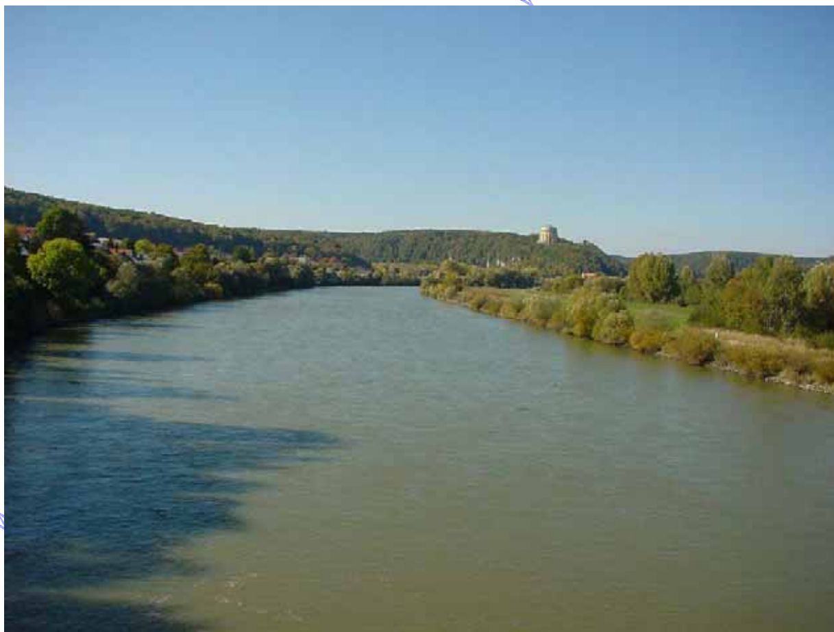
Figure 18 – SIMK® - station de débit au fil de l'eau Kelheim / Danube (commande WWA Landshut)
