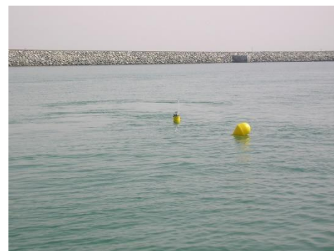
Surveillance de travaux aquatiques
